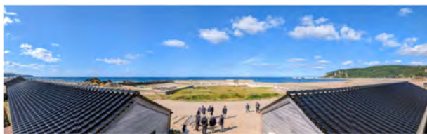
国道249号から望む輪島市の黒島漁港
